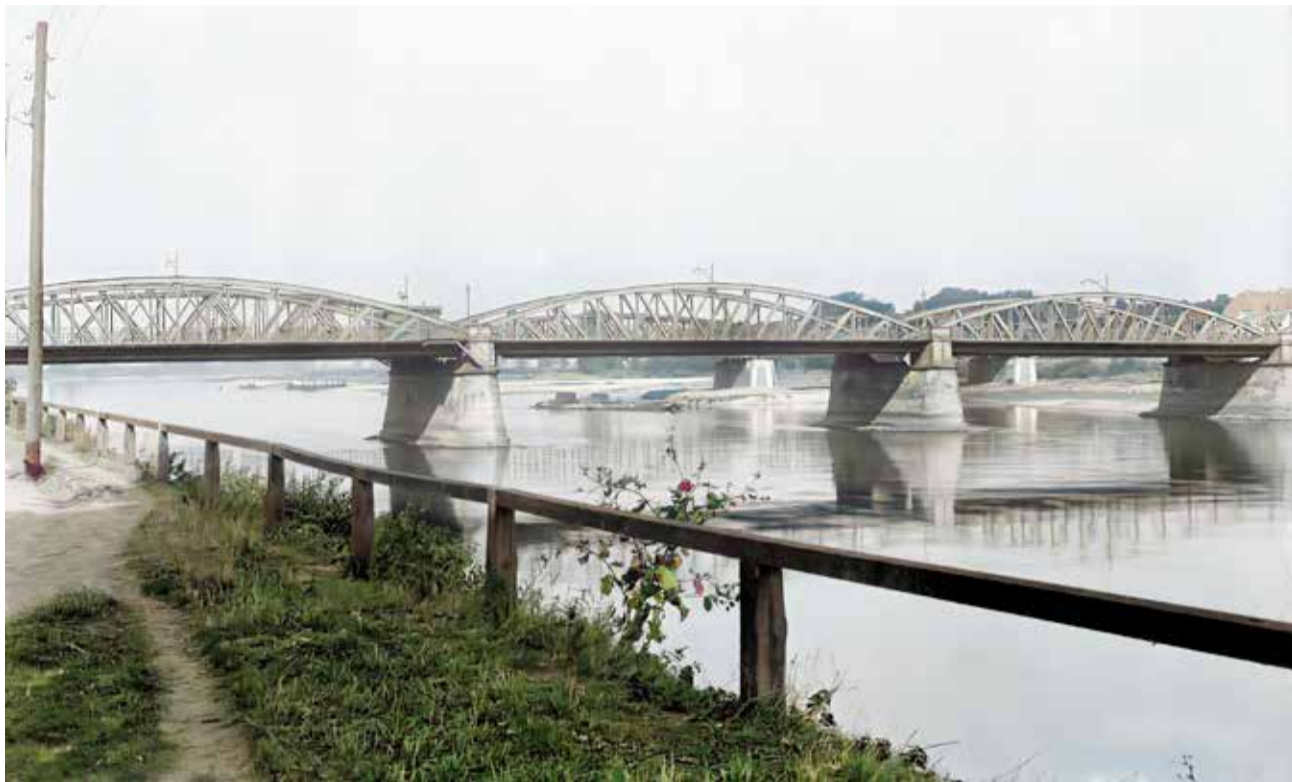
POWYŻEJ: WIDOK NA MOST KOŁOWY NA ODRZE OD STRONY KIETZ
